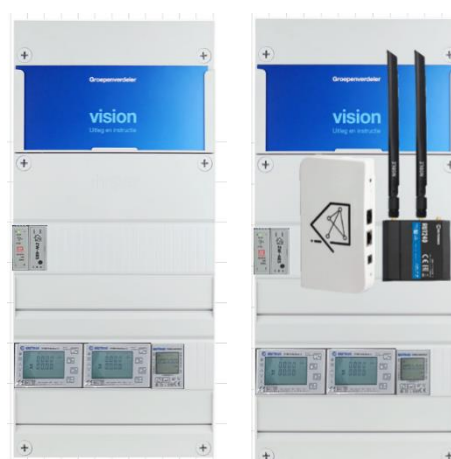
Figuur 4 - Monitoringskast voorbeeld 2 Links zoals uiteindelijk zichtbaar, rechts locatie gateway en 4g router
